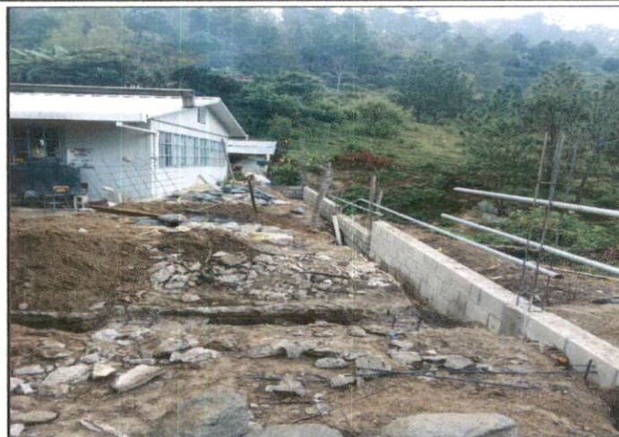
Foto 2: En el lado sur del establecimiento se expone el avance del cerco o muro perimetral.
